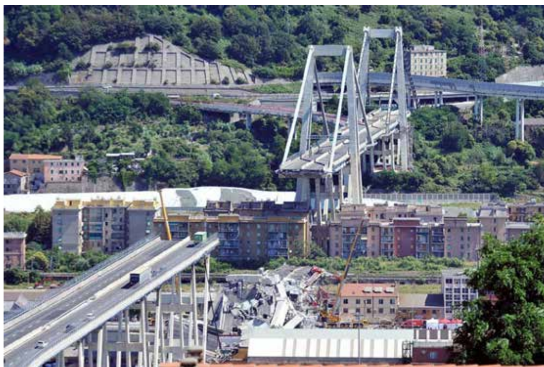
Il ponte Morandi dopo il tragico crollo
