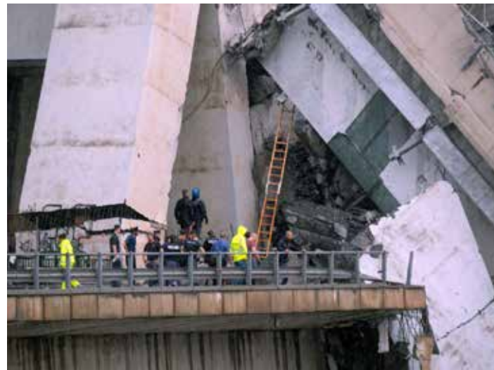
Le gigantesche macerie di cemento e ferro del ponte Morandi dopo il crollo e l'arrivo dei primi soccorsi
