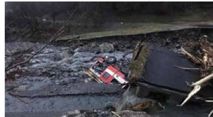
Ponte crollato nel Bellunese per il maltempo presso Gosaldo
