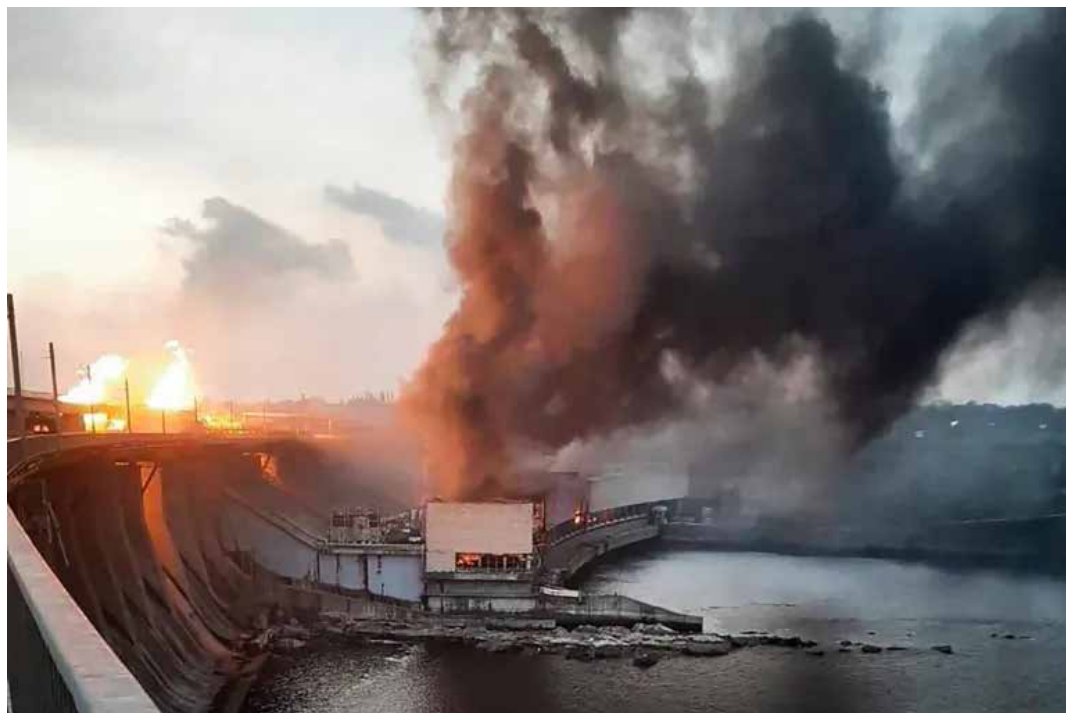
23 marzo 2024. Colpita dai missili russi la diga idroelettrica sul Dnipro
