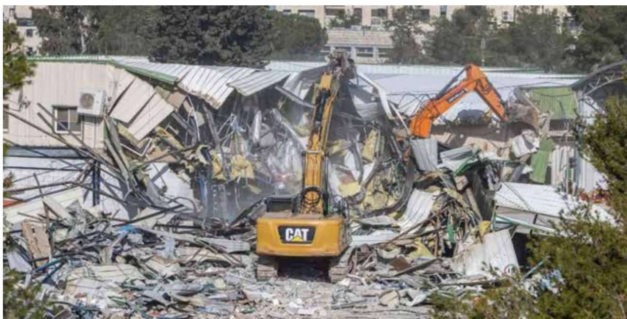
Gaza, 20 gennaio 2026. I bulldozer rimuovono completamente ciò che rimane della sede della UNRWA
